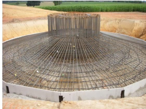
Photo 2 : Construction de l'armature d'une fondation
